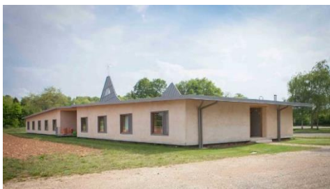
Les blés en herbe - Internat E4C2 - Rouillé (86) Maître d'ouvrage : Région Nouvelle-Aquitaine Maître d'œuvre : Dauphins Architecture
